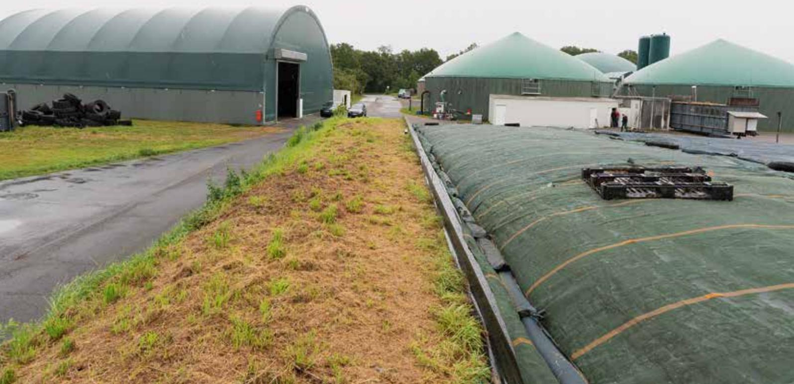
Die Harm Drewes Biogasanlage wird mit Gülle, abseparierten Feststoffen aus Gülle, Mist und nachwachsenden Rohstoffen „gefüttert“.
