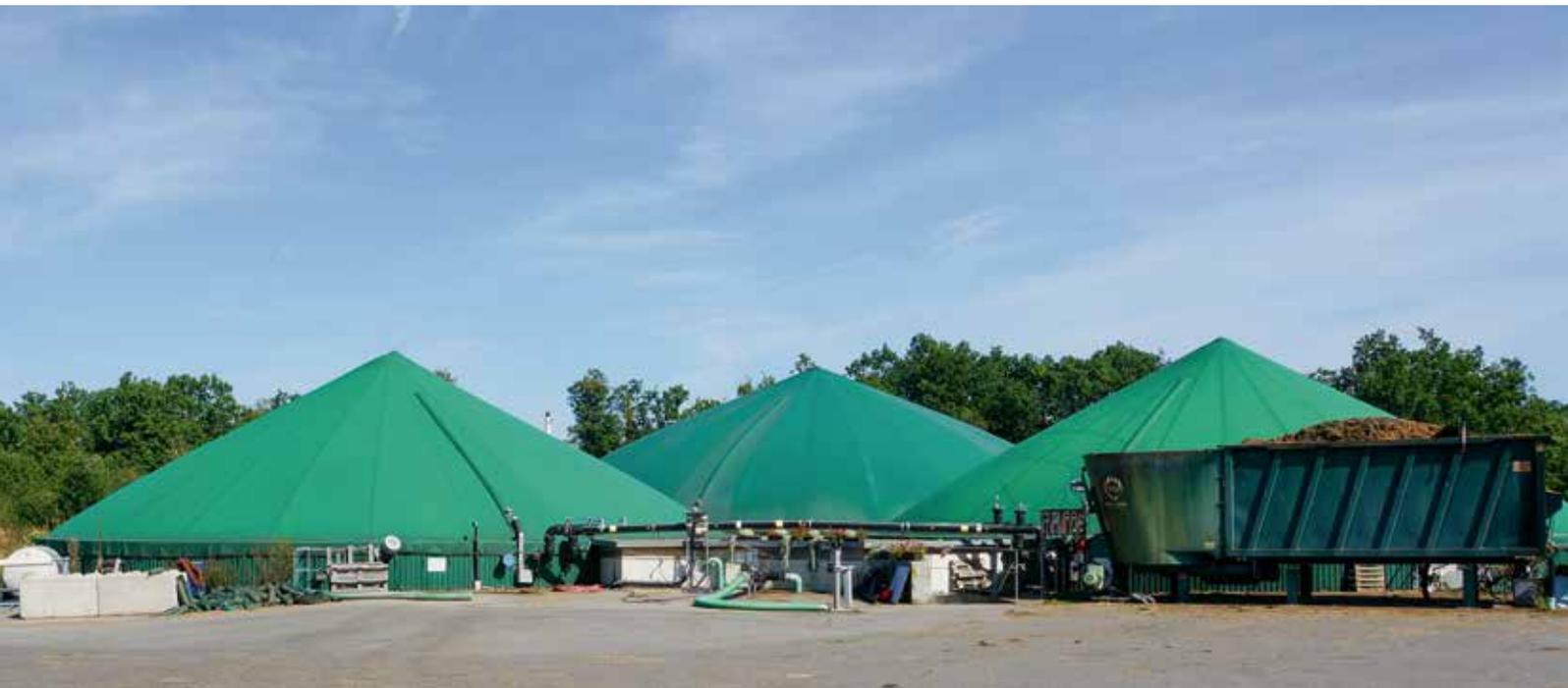
Die Biogasanlage in Wolfegg, Baden-Württemberg, verfügt über drei Fermenter.
