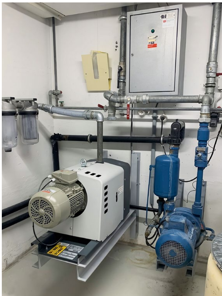
Eine Klauenpumpe ersetzt die Flüssigkeitsringpumpe beim Mischen und Entgasen von Mehrkomponentenharzen.
