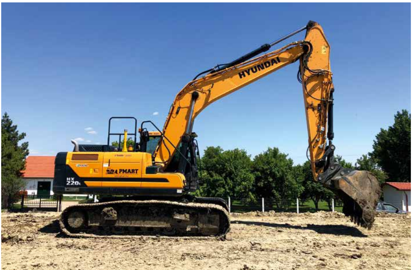
Für die Nachverfolgung ist der Tracker am Arm des Baggers befestigt und sammelt Daten zum Ist-Zustand.
